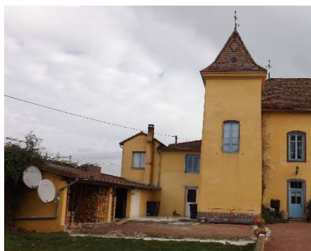
Vue sur la dépendance du château côté sud-ouest.
